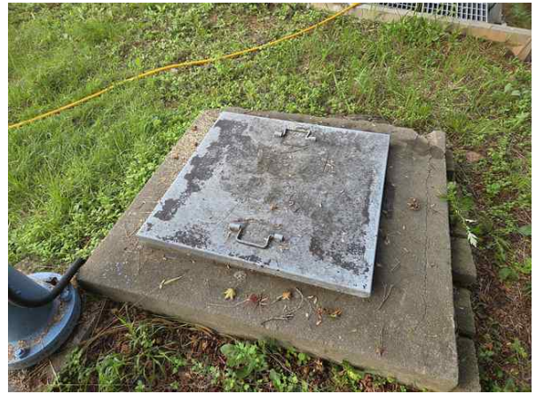
환기구 등의 덮개(장비 반입구) 현황
