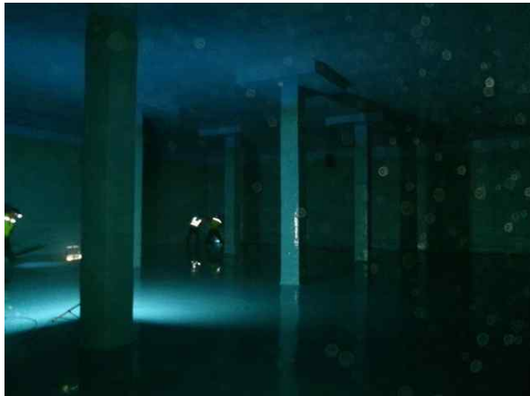
배수지 1지 내부 전경
