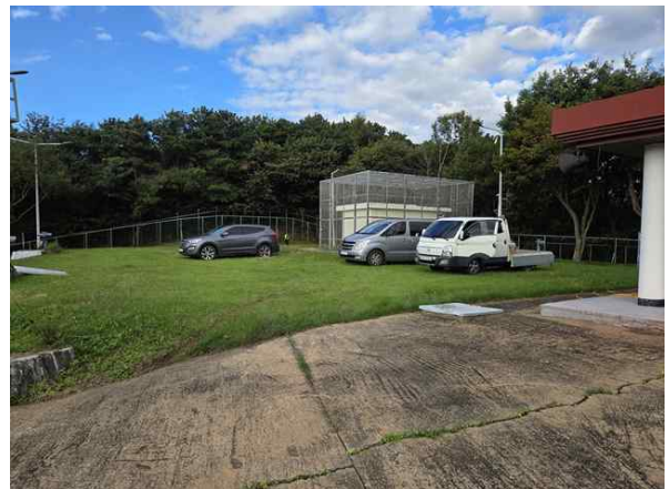
배수지 상부 현황
