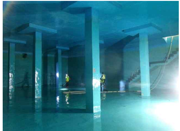
배수지 2지 내부 전경
