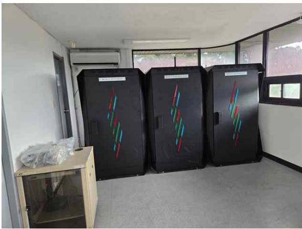
손상내용 전기실 전기설비 상태양호 손상원인 -
